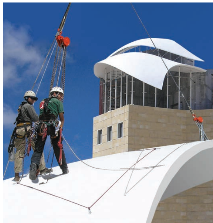
Het hijsen van een dakdeel voor het Rabin Centre in Tel Aviv. De mallen voor dit project zijn gefreesd door Nedcam in opdracht van Holland Composites.
