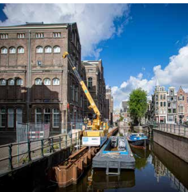
Het grootste gedeelte van het transport gebeurt over het water.
